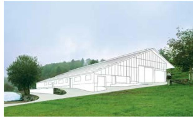
Die abgetrepte Einbettung des Baukörpers in die bestehende Hanglage verringert den Einsatz von Stützmauern.
